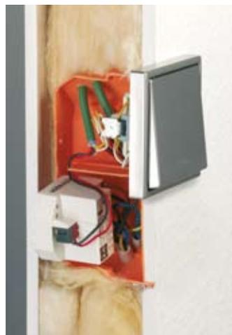
**Пусковой интерфейс EIB** может монтироваться вместе с кнопкой, на которую подаются управляющие воздействия. Перегородка позволяет разместить самые разнообразные типы напряжений в одной коробке, например светорегулятор вместе с кнопкой EIB.
