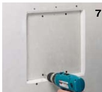
7 Закрепите на CW-профиле заготовку обшивки (см. рис. 1).
