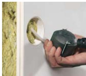
Просверливайте точно подгоняемое по размеру отверстие под проводку в дымопроницаемом варианте универсальной фрезой KAISER\*.
