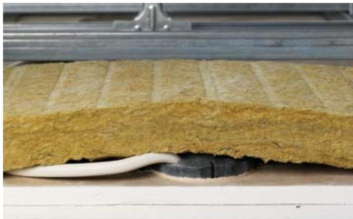
**С минеральной ватой** в соответствии со стандартом DIN 4102-17 монтаж соответствует классу огнестойкости F 60, с Rockwool/Termarock 100 — классу огнестойкости F 90.
