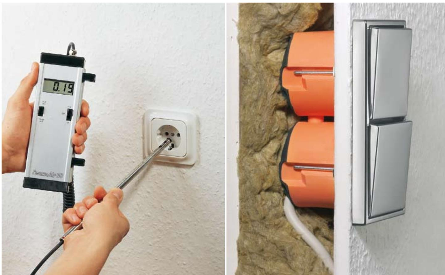
При **полый конструкции стен** герметичная оболочка здания, которая в значительной мере обеспечивается за счет растянутой по стене паронепроницаемой пленки, является важным условием для достижения предписанных показателей расхода энергии.
