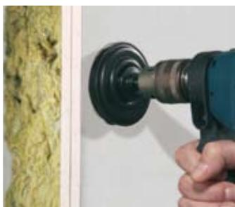
Монтаж так же прост, как установка обычной коробки для полой стены. Просверлите фрезой отверстие Ø 74 мм.
