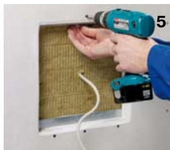
5 Зафиксируйте заготовку в нижнем смонтированном CW-профиле и закрепите ее самонарезающимися шурупами сквозь верхнюю обшивку.
