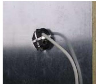
**В обшивке из жести** монтажное отверстие выполняется фрезой (арт. №: 1083-74). После выполнения отверстия для ввода кабеля с помощью универсальной фрезы KAISER коробка для полой стены HWD B15 крепится винтами
