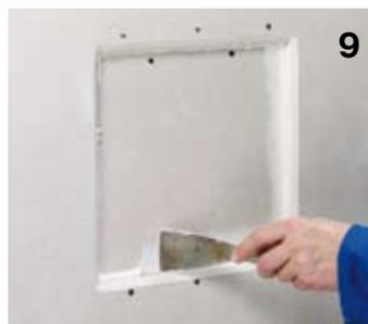
9 Тщательно зашпатлюйте, чтобы обеспечить установку второй обшивки заподлицо со стеной.
