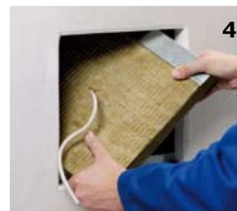
4 Установите в шахту заготовку закладываемой минеральной ваты с верхним CW-профилем.
