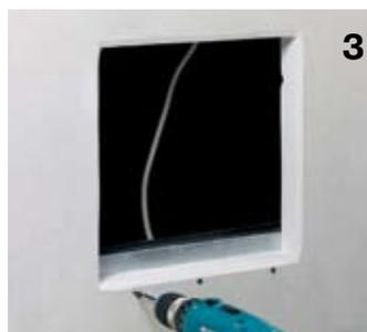
3 Установите CW-профиль и закрепите его с помощью самонарезающих шурупов сквозь обшивку.
