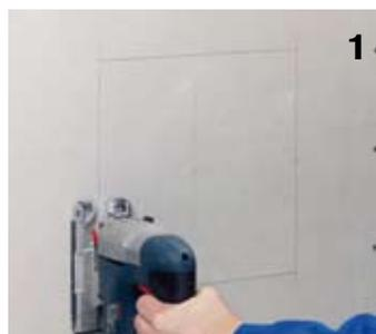
1 Просверлите отверстие размером от 300 x 300 до 300 x 600 мм (см. таблицу). Раскройный размер закладываемой вокруг минеральной ваты должен быть как минимум на 25 мм больше.
