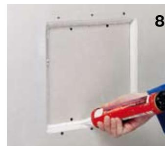
8 Запломбируйте обшивку со снятыми фасками на стыке со стеной противопожарным герметиком KAISER.
