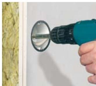
Крепление осуществляется по апробированной методике быстрого монтажа технологии KAISER для полых стен винтом FX<sup>4</sup>.
