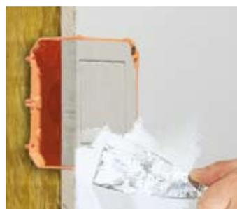
Проведите провода или трубы, поместите корпус в стену и зафиксируйте его посредством быстрого действия соединителя. Слегка зашпательте кромки (используйте пластиковый шпатель).
