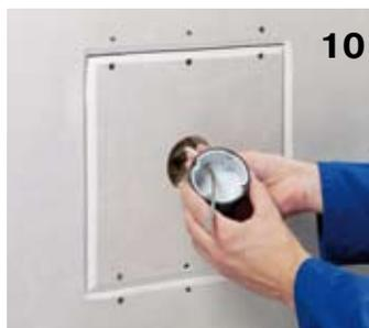
10 Выполните монтажное отверстие Ø 74 мм. Коробку для полых стен HWD 90 теперь можно установить как в обычную огнеупорную стену.
