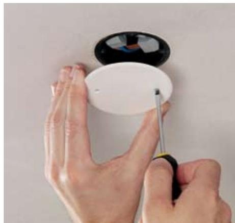
**Огнеупорная крышка** при потолках F 30 получает класс огнестойкости F 30, при потолках F 90 — класс огнестойкости F 90.
